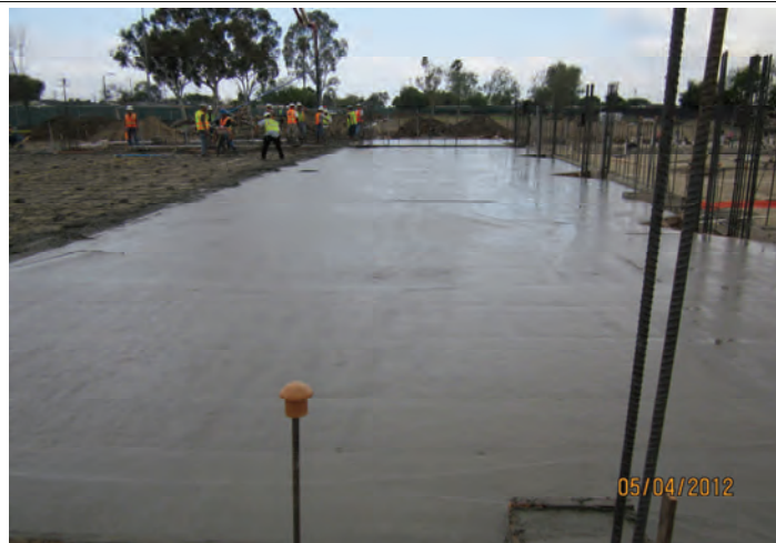
Slab Concrete pour (Gym Area)
