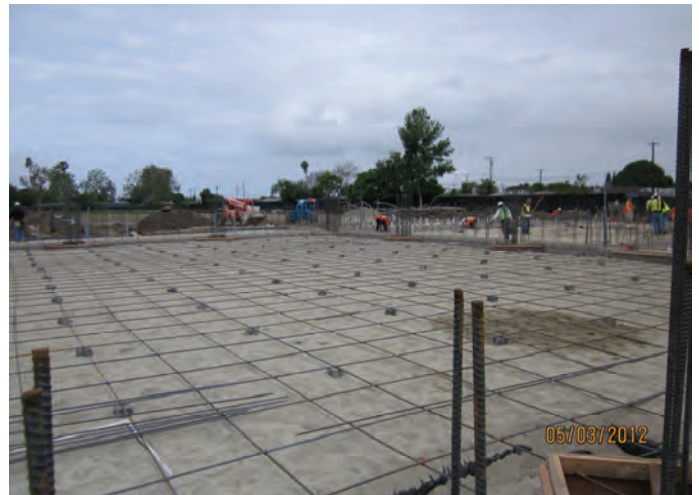
Preparation for Concrete Pour (Gym Area)
