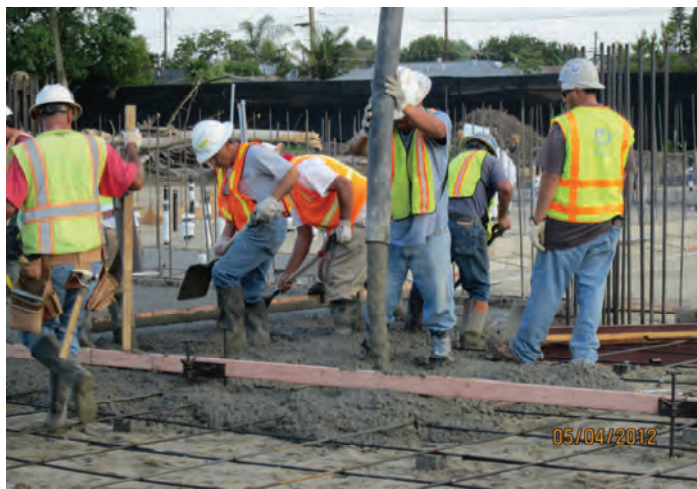
Slab Concrete pour (Gym Area)
