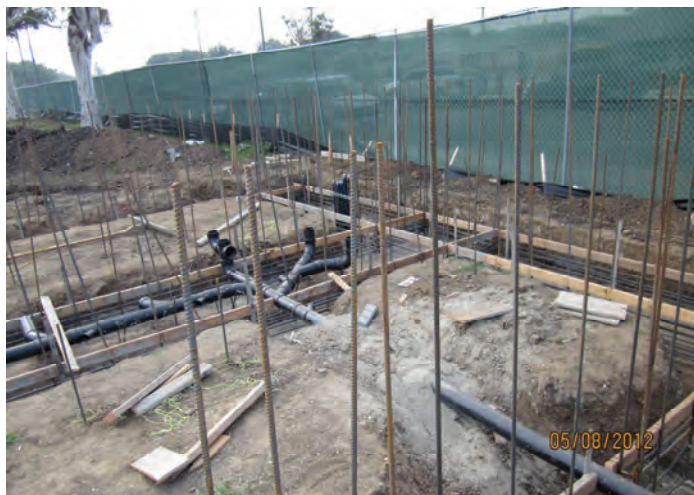
Preparation for concrete footing pour (Restroom Bldg)
