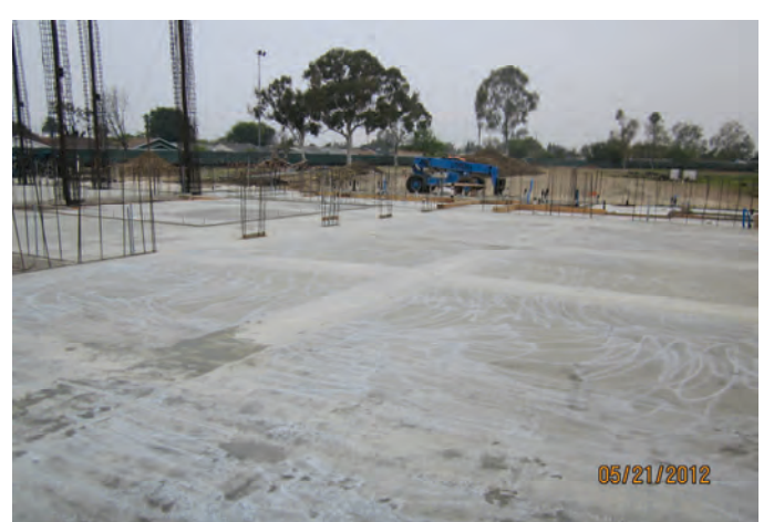
Slab Concrete Pour Complete (Remaining Areas)
