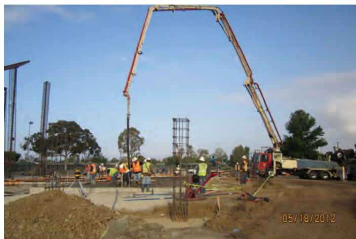
Slab Concrete Pour (Remaining Areas)
