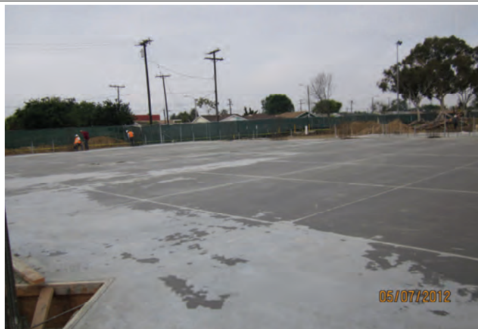
Slab Concrete Pour Complete (Gym Area)
