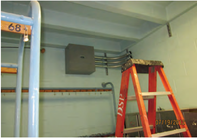
Data Conduit Installation (Pool)
