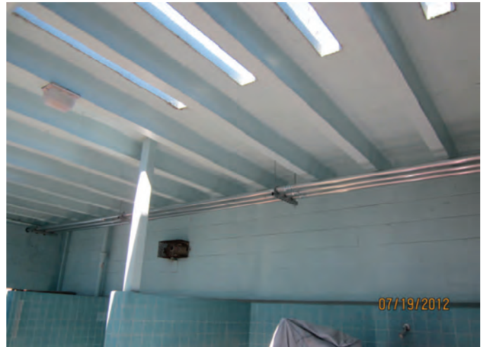
Data Conduit Installation (Pool)
