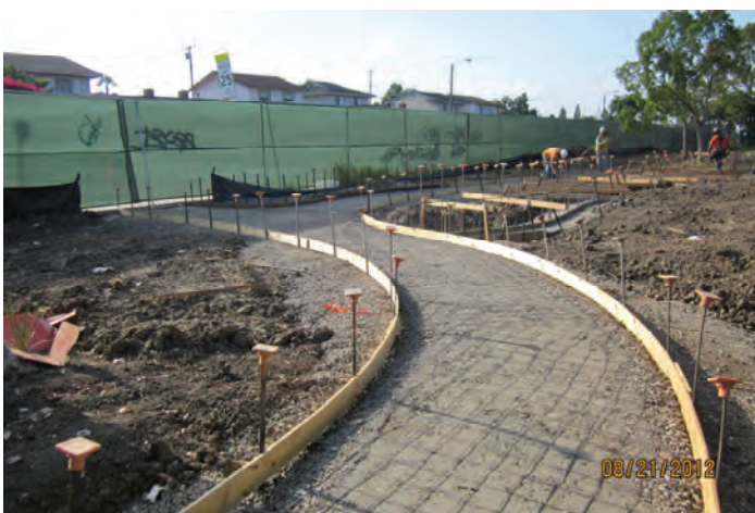
Walkway Preparation for Concrete Pour
