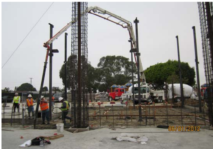
Concrete Pour — Remaining Areas
