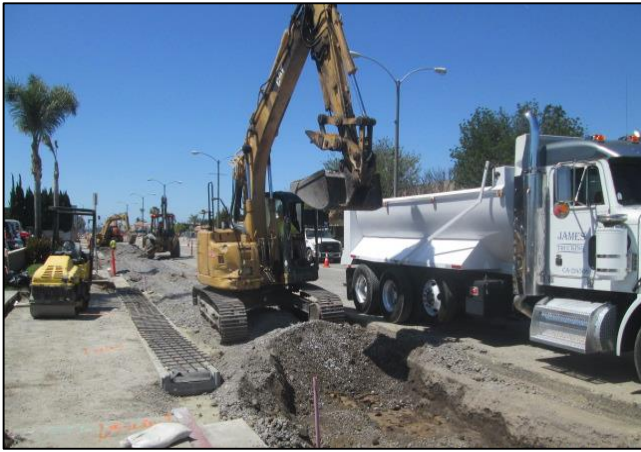
Removing Slag Backfill
