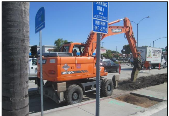
Breaker Removing Slag Backfill
