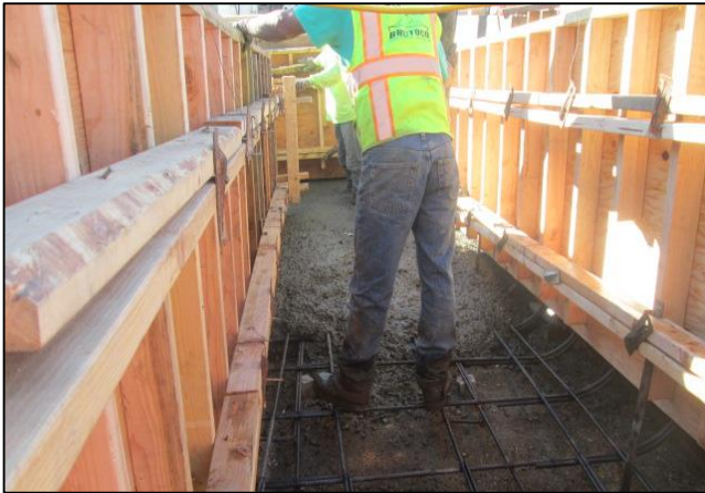
City Hall ADA Ramp PCC Pour
