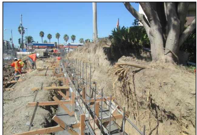
City Hall Retaining Wall Footing Concrete Pour
