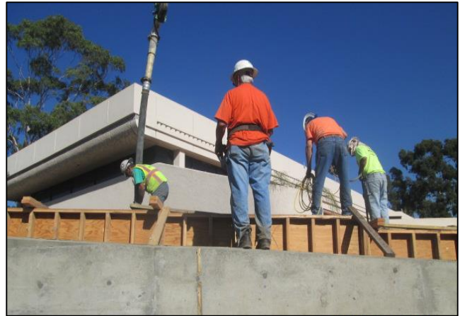
City Hall Retaining Wall PCC Pour
