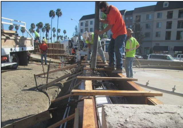
City Hall Fountain Bench PCC Pour
