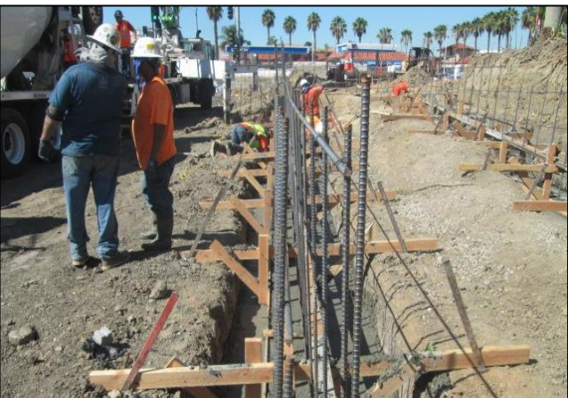
City Hall Retaining Wall Footing Concrete Pour
